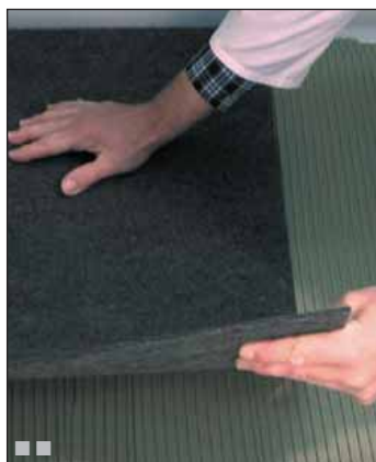
■ BOTACT®-Trittschall- und Entkopplungsplatte zuschneiden.
